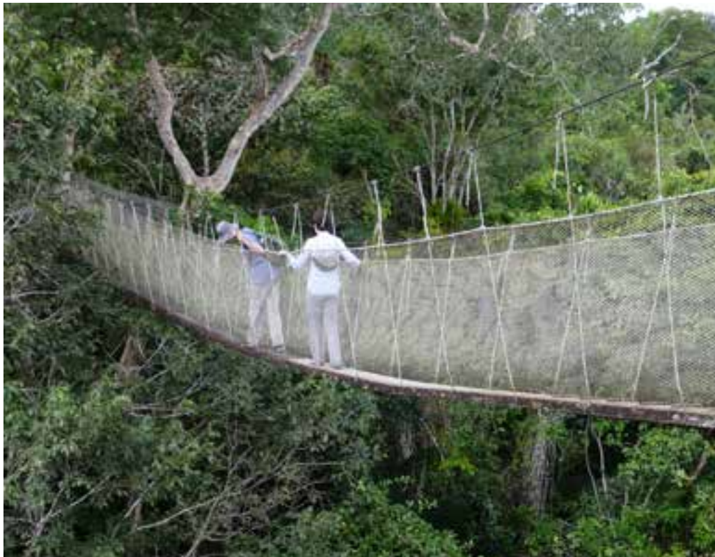
Puente colgante sobre la copa de los árboles.
