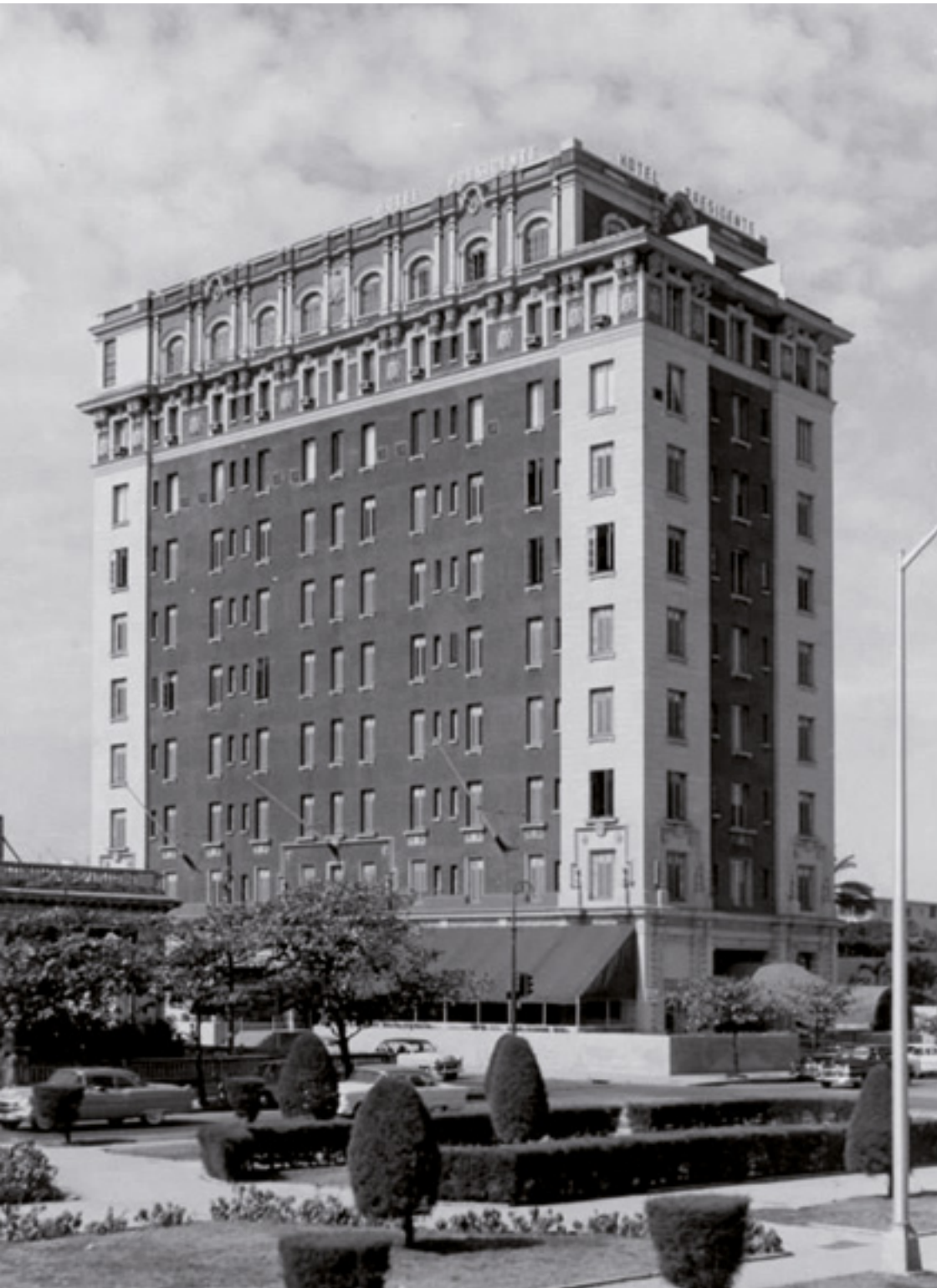
Hotel Presidente, ejemplo de construcción promovida por la presencia estadounidense.
